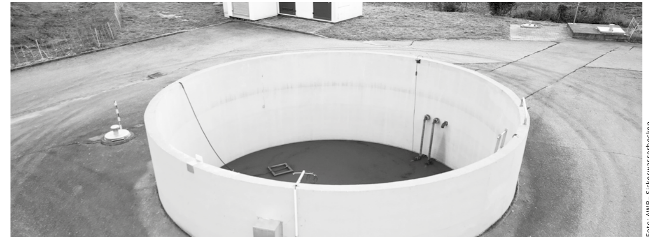
Foto: AWB - Sickerwasserbecken
