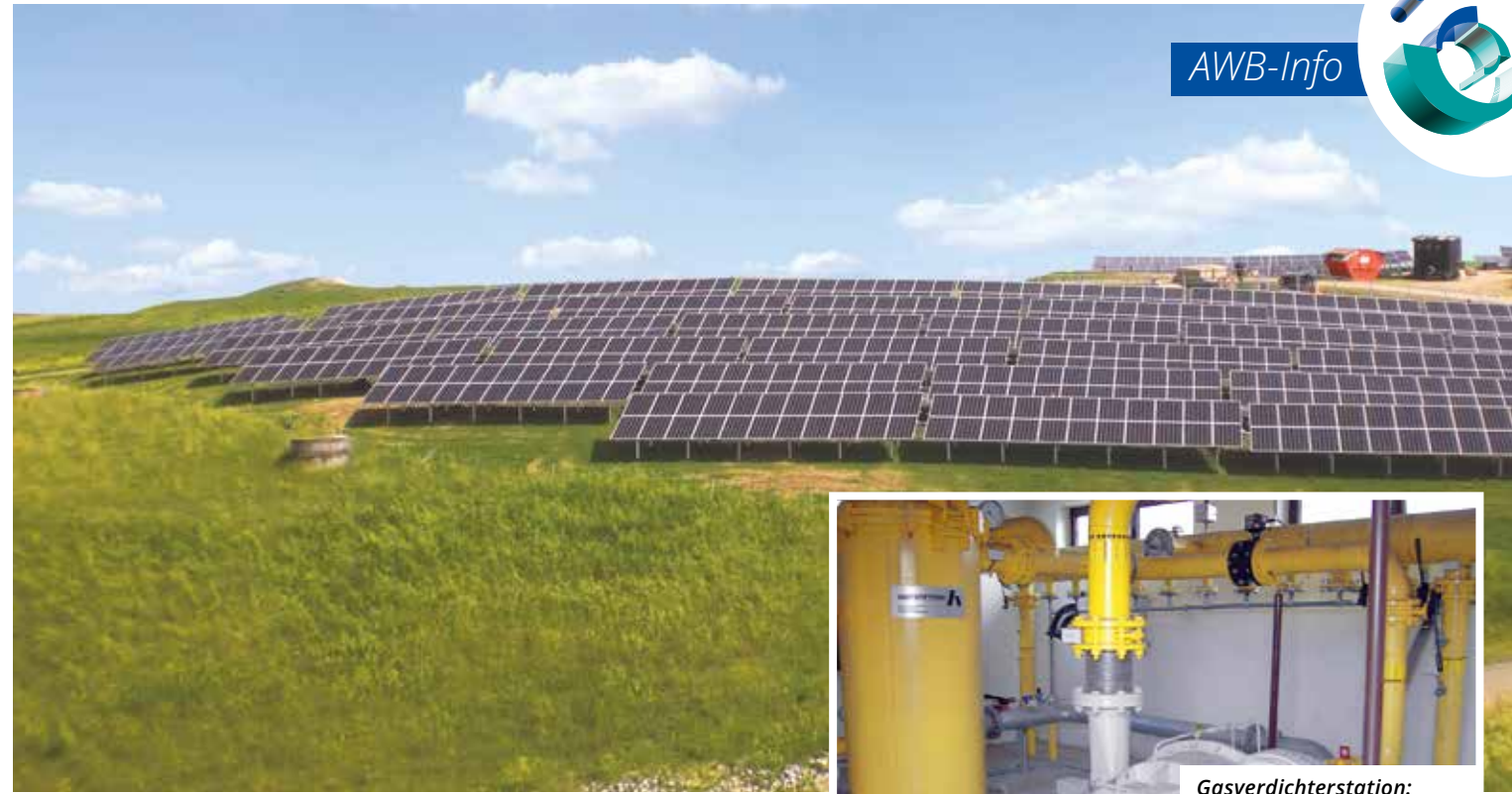
Gasverdichterstation: Deponiegase werden über 37 Gasbrunnen abgepumpt und hier erfasst.
