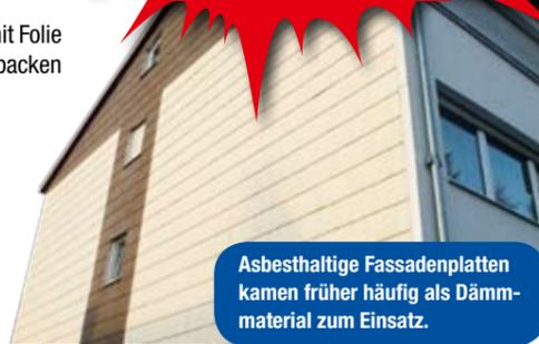
Asbesthaltige Fassadenplatten kamen früher häufig als Dämmmaterial zum Einsatz.
