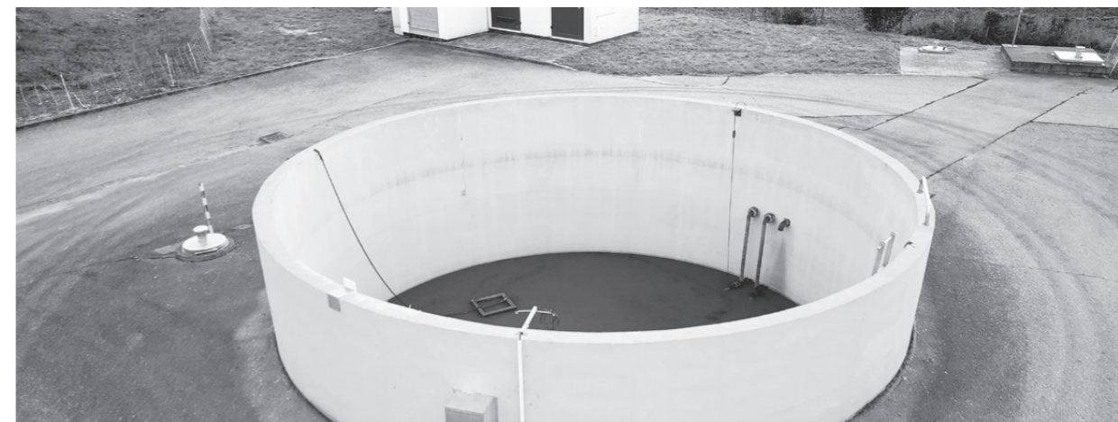
Foto: AWB - Sickerwasserbecken
