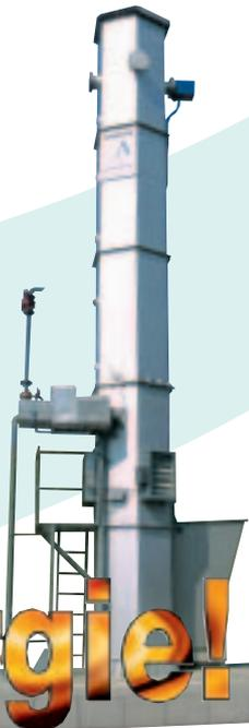
Die 12 Meter hohe Fackel verbrennt die anfallenden Deponiegase nahezu rückstandsfrei. Ein ungenutztes Energiepotential, dass der AWB in Zukunft zur Stromerzeugung nutzen will. Pro Jahr könnten so bis zu 1.875.000 kW ins öffentliche Stromnetz eingespeist werden. Damit könnte umgerechnet der Jahresbedarf für ca. 350 Haushalte gedeckt werden.
